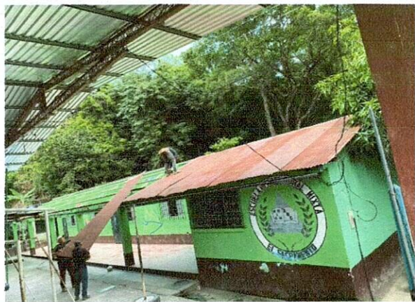
FOTO 1: Instalación de techo con estructura de metal tipo pórtico con cobertura de lámina troquelada calibre 26 a modulo 1, 2, 3 y area de direccion.
