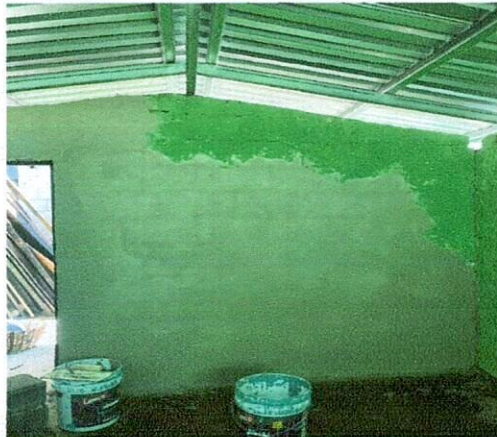
FOTO 2: Cambio de estructura de madera a metal y cubierta de lámina troquelada calibre 26, mejoramiento de puerta en area de cocina
